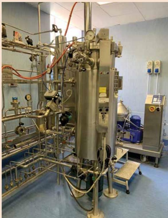
Fermentatore da 500 litri per la messa a punto di processi pilota di produzione in ambito biofarmaceutico
